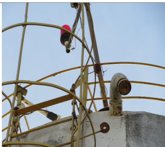
Autor: AMAE Descrição: REL Miriam Resende – Para-raios sem fiação de aterramento.
